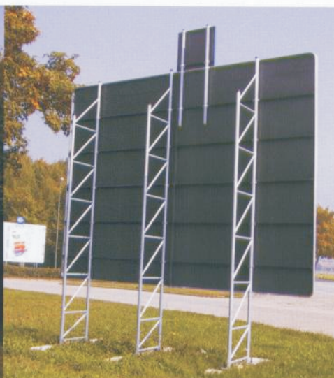
Lageplanrückseite mit Gittermastkonstruktion
